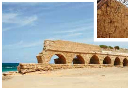
Alte Aquäduktbrücke, Caesarea
