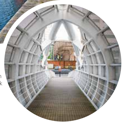
Brücke über den Princess-Dock
