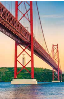
Brücke des 25. April, Lissabon
